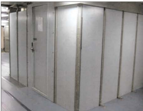
Помещение в отсеке из переносных переборок
